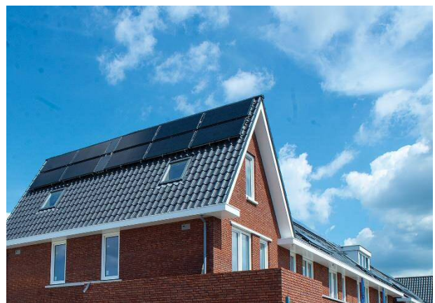
Beispiel einer Flachdachanordnung auf einem Wohnblock in Ridderkerk, Niederlande.
