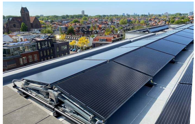
Beispiel einer Flachdachanordnung auf einem Wohnkomplex in Delft, Niederlande.
